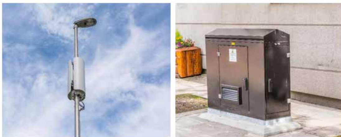
Figure 6: Exemple d'un système de petite antenne et du boîtier qui l'accompagne
