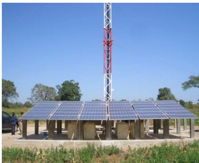
Figura 12: Estación solar en el emplazamiento de una estación móvil radioeléctrica en Senegal
