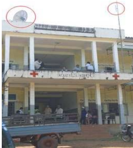
Figure 4 – Concentrateur, point d'accès à l'internet
