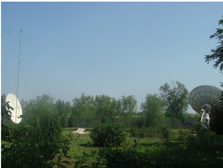
FIGURE 3 Deux antennes de secours de 7,3 m
