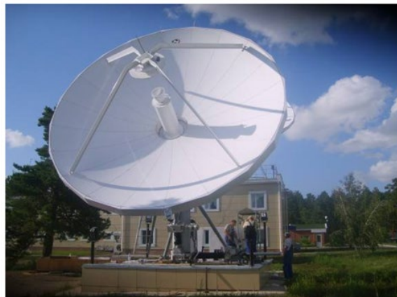
Антенная система с диаметром антенны 7,3 м
