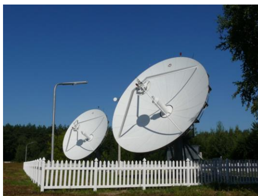
Антенная система станции спутникового радиоконтроля УГЦР
