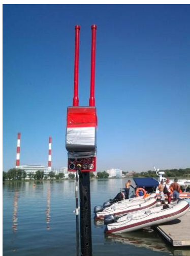
FIGURA 7.18 Estación de acceso inalámbrico en el Centro de Deportes de Remo
