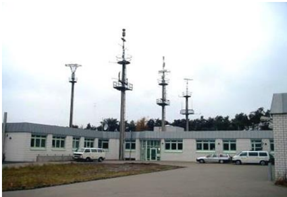
Station de contrôle des émissions radioélectriques de Krefeld/Rheurdt
