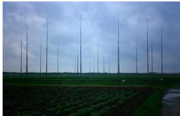
La estación de comprobación técnica radioeléctrica de Rheurt cerca de Krefeld es una estación de radiogoniometría de onda corta. Debido al entorno homogéneo, y también para evitar emisiones nocivas y errores (DF) como resultado de los edificios en los alrededores, el radiogoniómetro de onda corta se construyó lejos de esos edificios en una explanada destinada únicamente a fines agropecuarios y se opera por control remoto.
