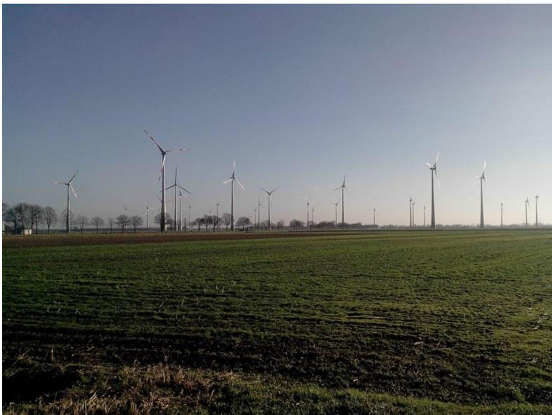
Se construyeron 29 turbinas eólicas ENERCON E-70-4 con una potencia efectiva de 2 MW y ENERCON E-66-1 con una potencia efectiva de 1,8 MW en el parque eólico. La altura del eje de todas las turbinas es la misma: 98 m. Las turbinas están equipadas con palas de rotor de última generación (punta cónica) para mejorar la utilización de la energía eólica.
