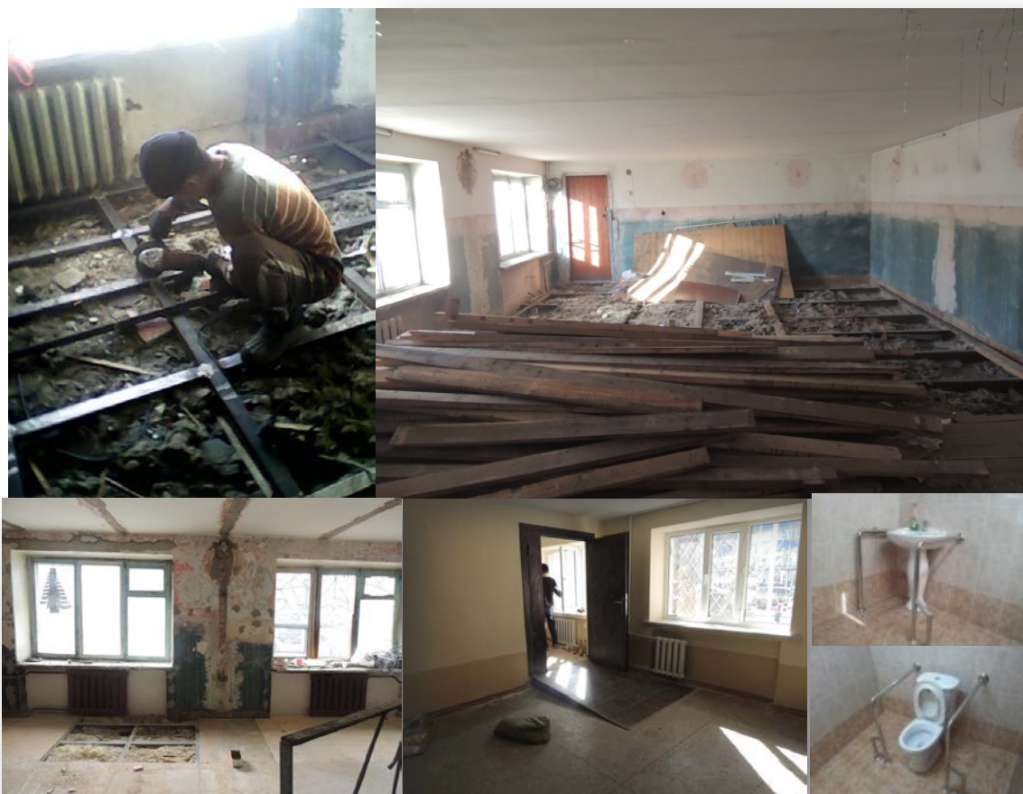
Рис. 2.1. Во время ремонтно-подготовительных работ помещения для центра
