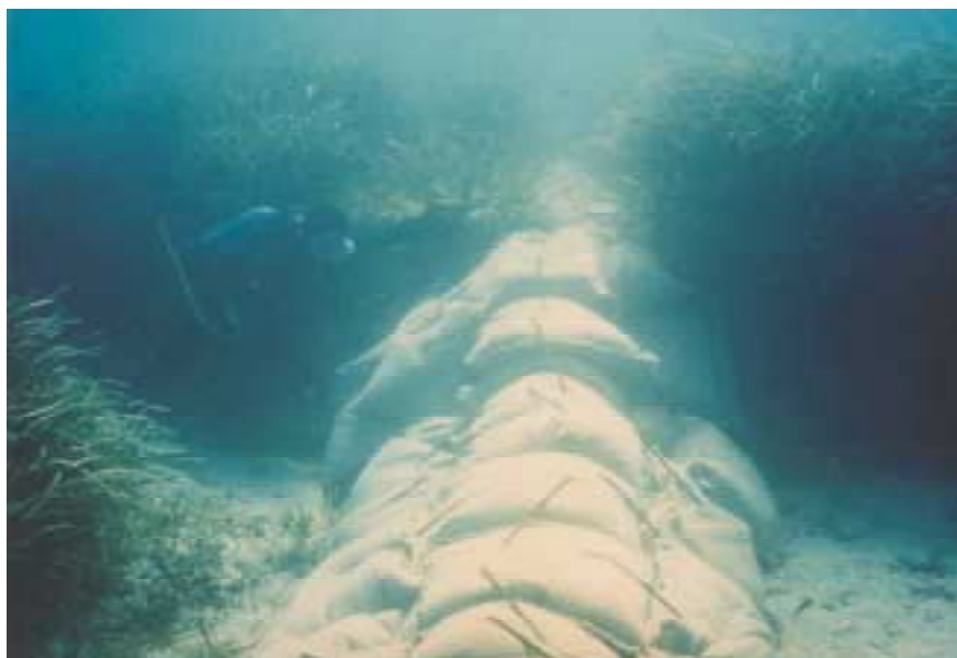
Figure I.2/L.28 – Protection assurée au moyen de sacs de sable-ciment placés au-dessous, de part et d'autre et au-dessus du câble
