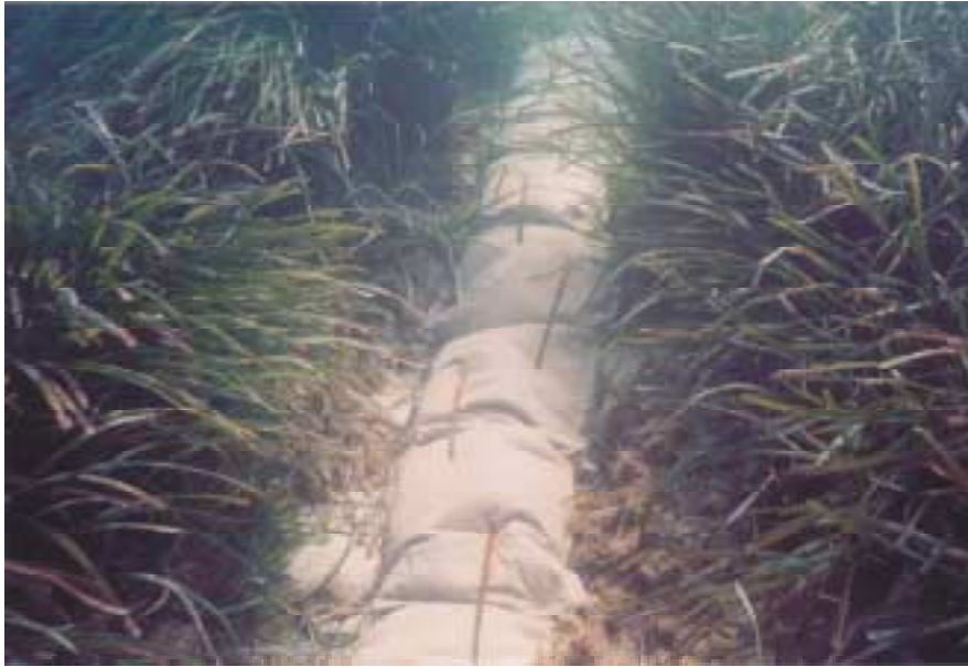
Figure I.4/L.28 – Photo d'un exemple de protection externe pour câble, avec coquilles en fonte recouvertes de sacs de béton-sable
