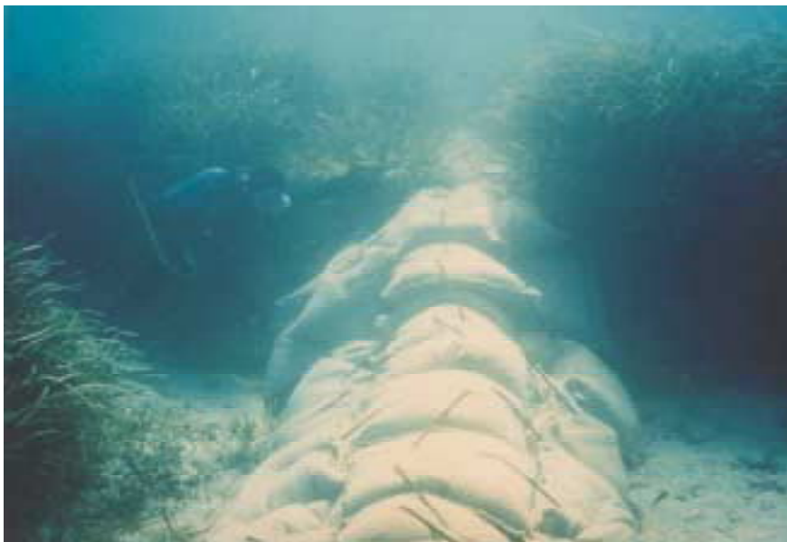
Figura I.2/L.28 – Protección con bolsas de arena y hormigón bajo, sobre y a los costados del cable
