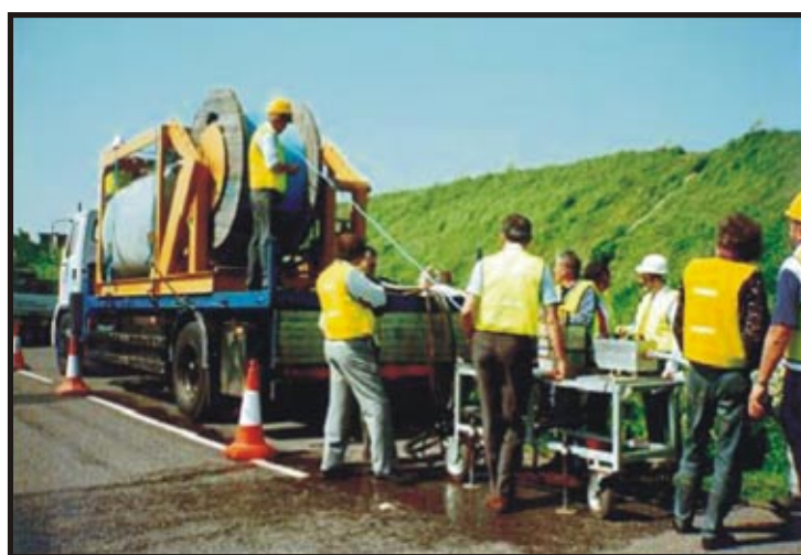
Figure I.2/L.61 – Chenillette appliquant une force sur le câble pour le pousser à l'intérieur de la conduite
